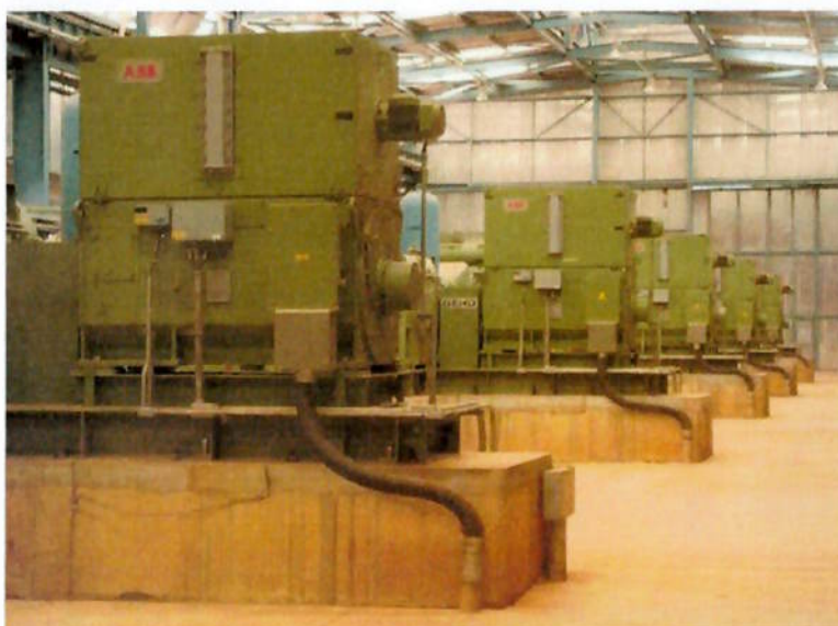
Figura 4 – Terminal de bombeamento da polpa localizado na planta industrial
